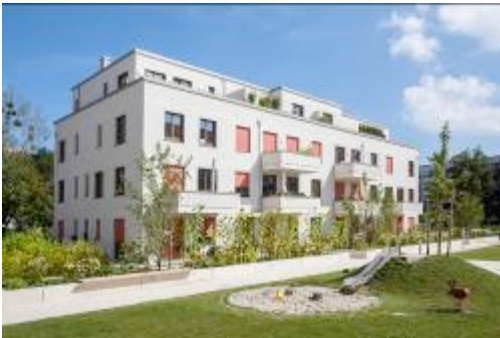
Qualitätsvoll wohnen zu bezahlbaren Preisen: In der Baugemeinschaft „gemeinsam größer“ realisierten 26 Bauparteien im Domagk-Park im Münchner Norden zwei Mehrgeschosser in Hybridbauweise aus Holz und Beton. (Foto: Knauf/Bernd Ducke)
