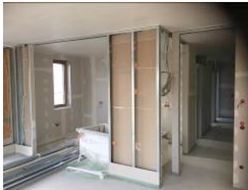
Die nicht tragenden Raumtrennwände entstanden in Trockenbauweise. (Foto: Knauf)
