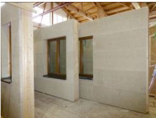
Die bis zu 8 m langen, geschosshohen Fassadenelemente wurden im Werk beim Holzbauspezialisten Ambros gefertigt. (Foto: Knauf)
