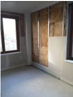
Die innen vor die Fassade gestellte Knauf Vorsatzschale trägt dank der Ausfachung mit Mineralwolle mit ECOSE Technology zum Wärmeschutz bei und dient als Installationsebene für die elektrischen Leitungen. (Foto: Knauf)
