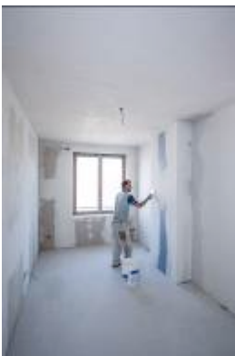
Schächte sind generell mit Knauf Diamant bekleidet, um Fließgeräusche besser zu dämmen. (Foto: Knauf/Bernd Ducke)
