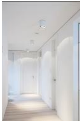
Schattenfugen schaffen den eleganten Abschluss der Wände. (Foto: Knauf/Bernd Dücke)
